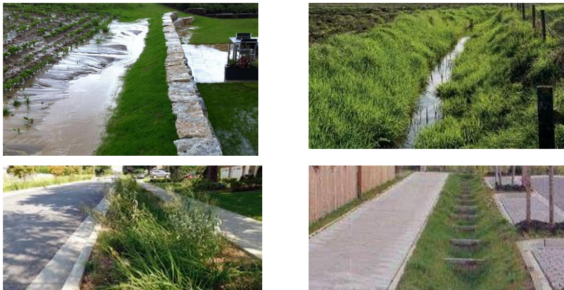
FIGURE 13 : EXEMPLES DE FOSSÉS D'ÉVACUATION ET DE NOUES
